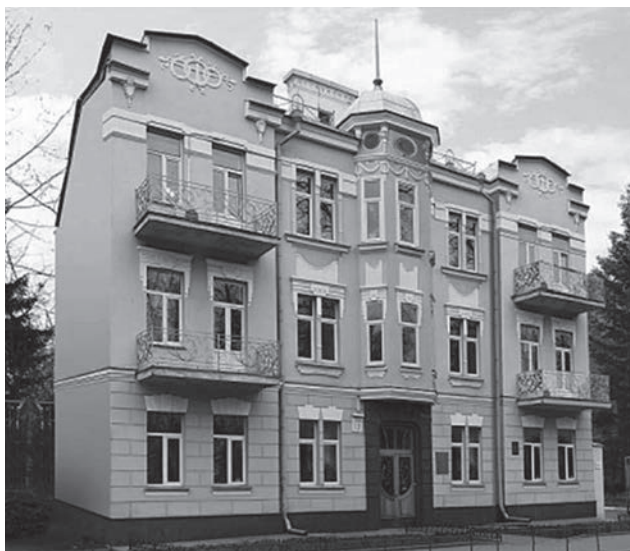
Будівля Національної академії медичних наук України, м. Київ, вул. Герцена, 12
