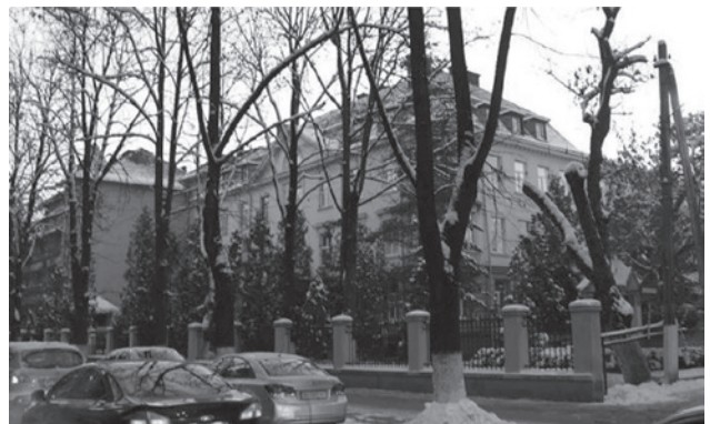
Сучасний вигляд будівлі клінічної лікарні на вул. Івана Франка, 17. [https://westnews.com. ua/stanisлавiv-vchora-i-sogodni-yak-viglyadala- vulitsya-franka-100-rokiv-tomu-foto/]
